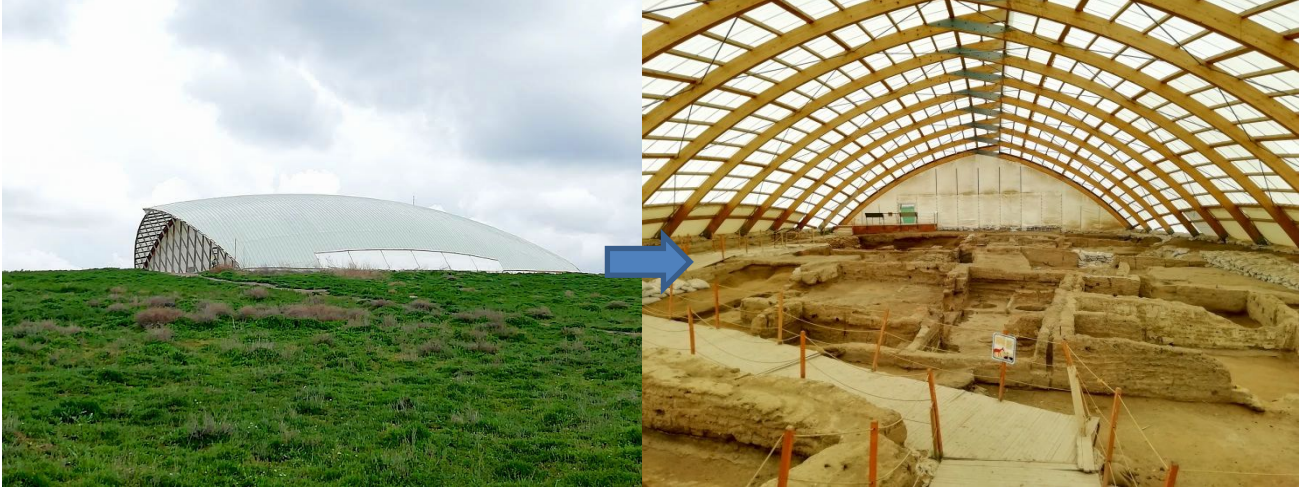
Fotoğraf 1. Doğu Çatalhöyük Kuzey Korunağının Dış ve İç Mekân Görüntüsü
