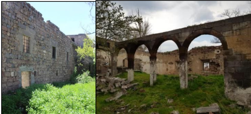
Şekil 6: Okul binasının günümüzdeki durumu (Bağran, 2019).
