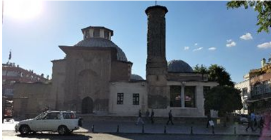
Şekil 4: İnce Minareli Medrese'nin Doğu Cephesi
