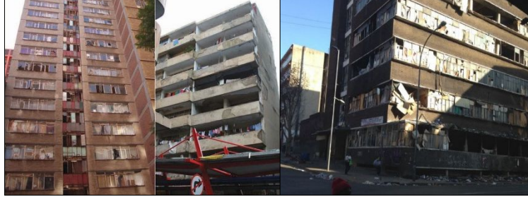
Fotoğraf 5. Proje alanındaki terk edilmiş yapılar (Url-11)
