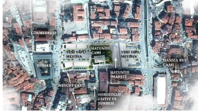
Şekil 8:Yeni yapı çalışmalarınca oluşan yeni durum (Tokat Belediyesi Arşivi).
