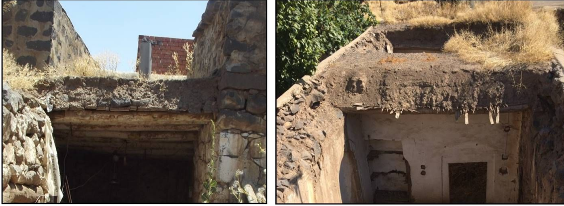
Resim 10. Üst örtü detayı / detail of earth roof covering
