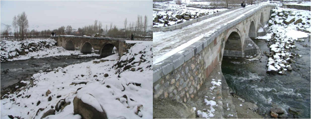
Fotoğraf-23,24: Kaynarca Köprüsü Onarım Sonrası Görünüşleri (Ş. Öztürk)
