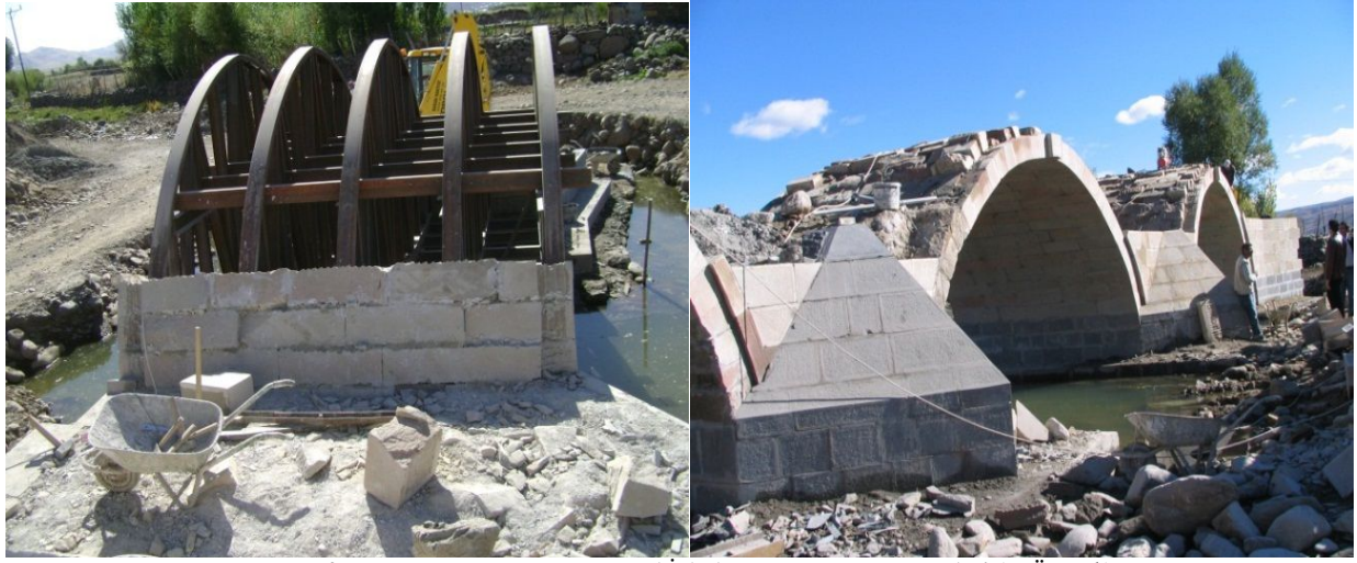
Fotoğraf-9,10: Kaynarca Köprüsü Metal İskele ve Onarım Görünüşleri (Ş. Öztürk)
