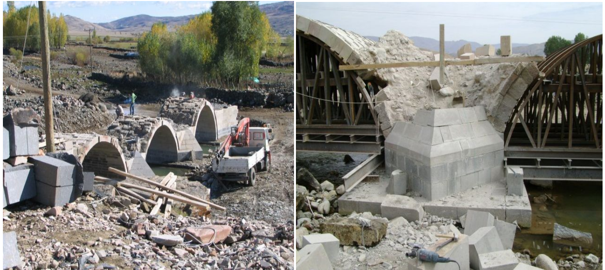
Fotoğraf-15,16: Kaynarca Köprüsü Kemer ve Selyaran Onarım Görünüşleri (Ş. Öztürk)
