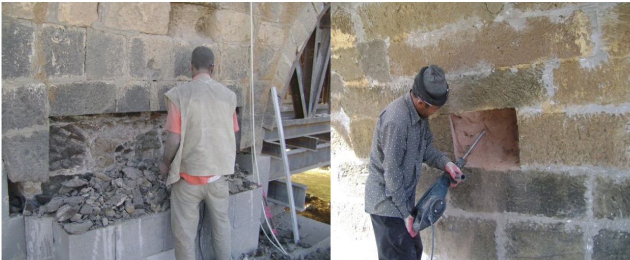
Fotoğraf-11,12: Kaynarca Köprüsü Raspa ve Onarım Görünüşleri (Ş. Öztürk)
