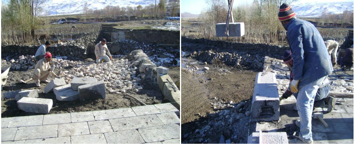
Fotoğraf-19,20: Kaynarca Köprüsü Döşeme ve Korkuluk Onarım Görünüşleri (Ş. Öztürk)
