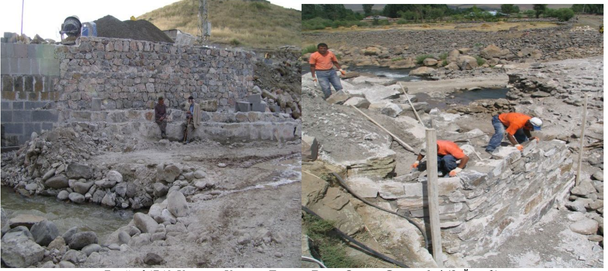
Fotoğraf-17,18: Kaynarca Köprüsü Tempan Duvar Onarım Görünüşleri (Ş. Öztürk)
