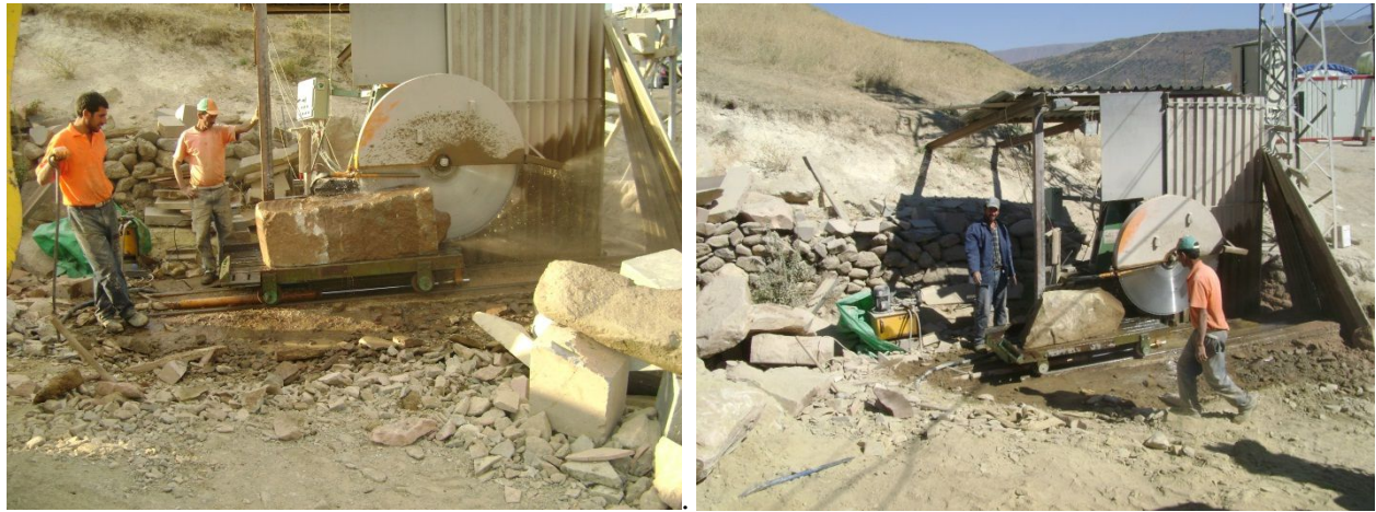
Fotoğraf-5,6: Kaynarca Köprüsü Onarım Taş Kesim ve Hazırlama Görünüşü (Ş. Öztürk)
