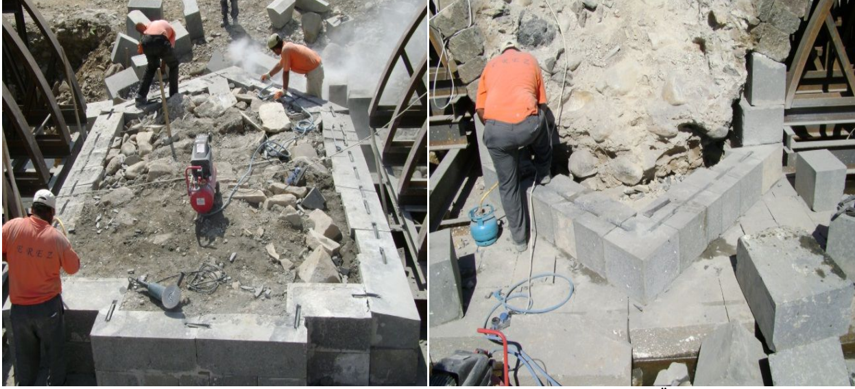
Fotoğraf-13,14: Kaynarca Köprüsü Ayak ve Selyaran Onarım Görünüşleri (Ş. Öztürk)
