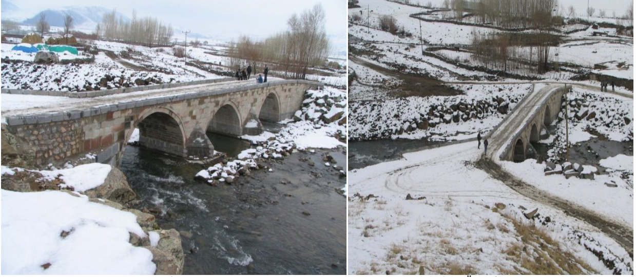
Fotoğraf-21,22: Kaynarca Köprüsü Onarım Sonrası Görünüşleri (Ş. Öztürk)
