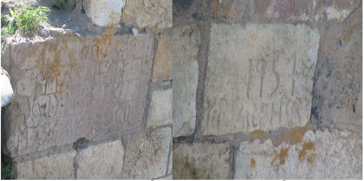
Fotoğraf-3,4: Kaynarca Köprüsü Özgün Kitabe ve Onarım Kitabe Görünüşü (Ş. Öztürk)
