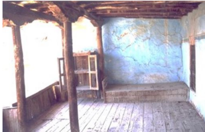
Resim 10. Hanayda serpin yerleşimi ve döşeme kaplaması
