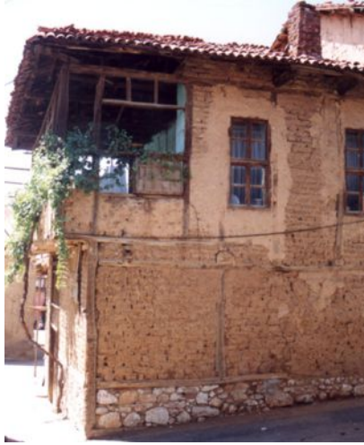
Resim 20. Yalvaç evlerinde taşıyıcı duvarlar ve duvarlara yerleştirilen dikmeler
