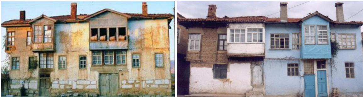
Resim 12. Yalvaç geleneksel konutlarında çıkmalar
