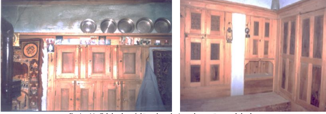
Resim 11. Odalarda raf düzenlemeleri ve ahşap gömme dolaplar
