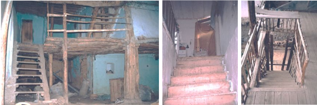
Resim 25. Hanayda ahşap kirişli merdiven korkuluğu ve uygulamaları
