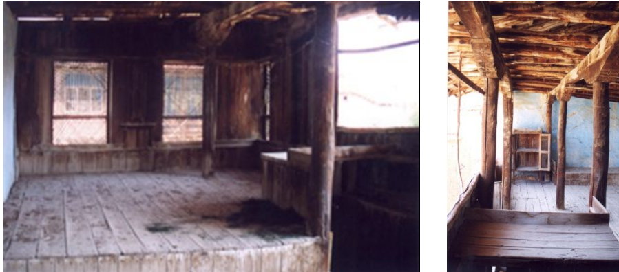
Resim 23. Hanayda Köşk Döşemesi ve ahşap taşıyıcılar
