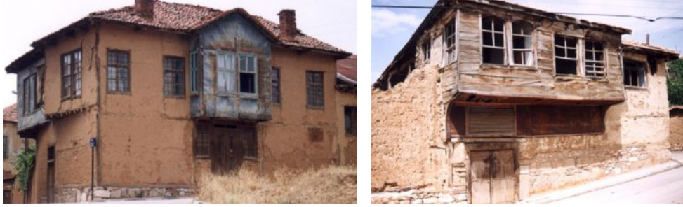
Resim 21. Cephelerde çinko kaplamalı çıkmalar ve dört pencereli köşk örneği
