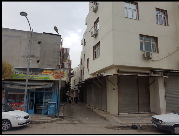
Foto 3. Suluç Şehri'ndeki Mahremiyet Sorunu Oluşturan Eski ve Yeni Binalar.
