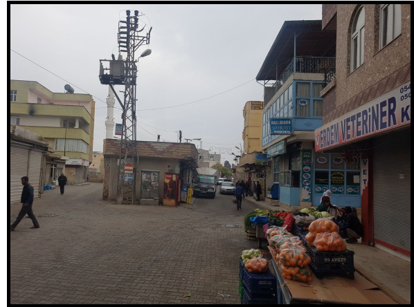
Foto 6: Yer Altına Alınmamış Elektrik Şebekesi.
