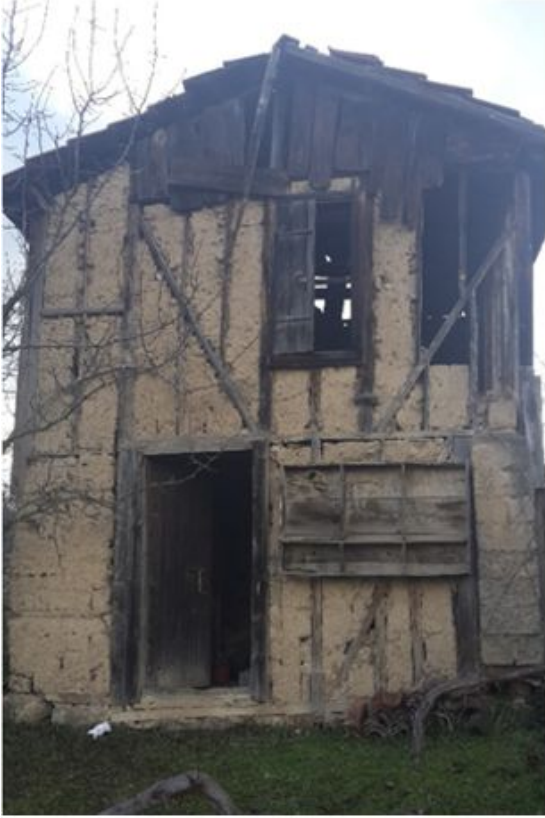
Fotoğraf 1 Tarık Aktekin Evi Giriş Cephesi. Kapının yanındaki duvarda ahşaptan kerpiç kalıbı asılmıştır (Bölükbaşı Ertürk 2018)
