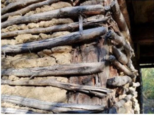
Fotoğraf 7 Bulak Köyü Çayın Harmanı Mevkii Bağ Evi Dikmelerin Üzerine Çivilerle Çakılmış Ağaç Dalları. (Bölükbaşı Ertürk 2018)
