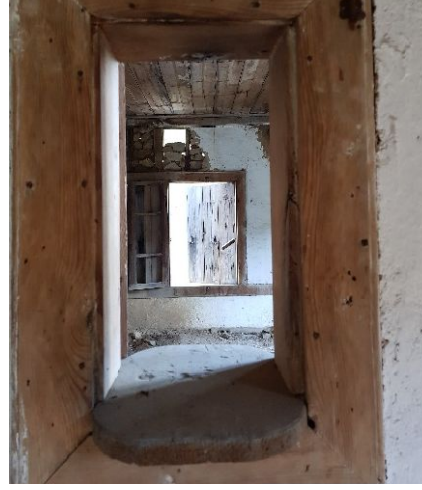
Fotoğraf 16-17. Güneyde bulunan odadaki ocak ve gusülhane/yüklük (solda), bu oda ile kuzeydoğudaki oda arasında duvara açılmış servis penceresi. (Bölükbaşı Ertürk 2018)
