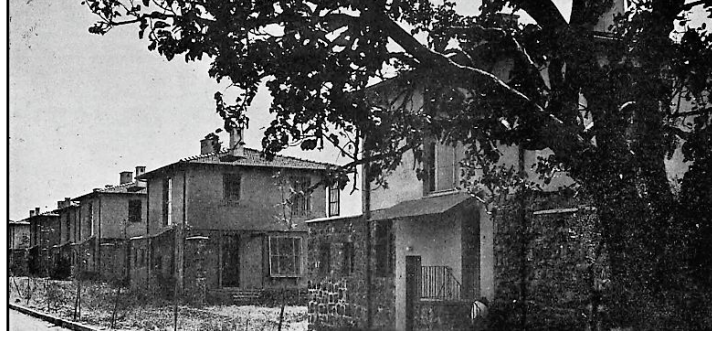
Şekil 7. Şenesenevler Yapı Kooperatifi F Tipi Evlerin Görünümü.
