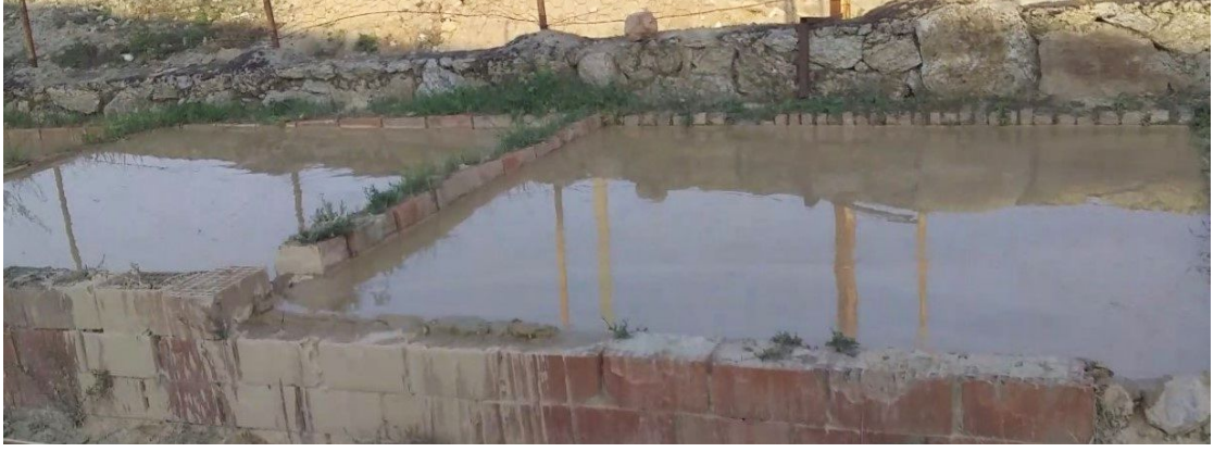
Resim 6. Havuzlarda Sıvı amurun Havuzlarda Bekletilmesi
