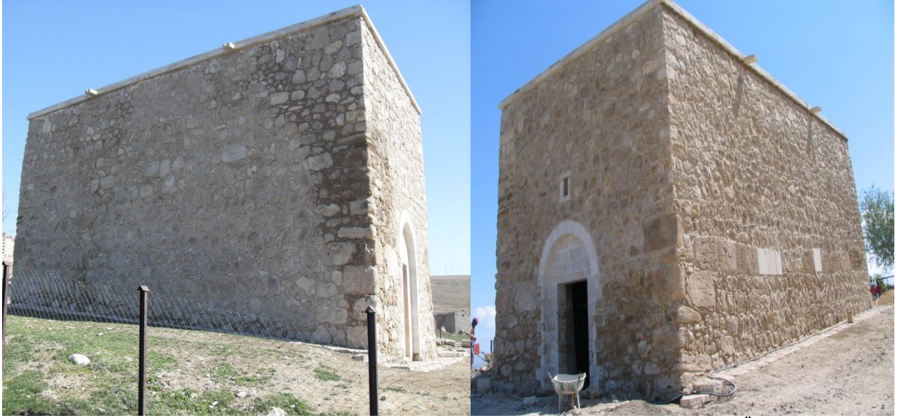
Şekil 26,27. Edremit Kilisesi Güneybatı ve Kuzeybatı Cephe Onarım Sonrası Görünümleri (Ş. Öztürk)
