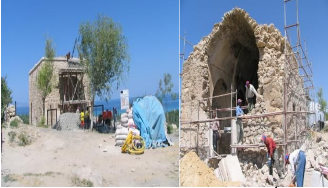
Şekil 20,21. Edremit Kilisesi Güneydoğu ve Güneybatı Onarım Görünüşleri (Ş. Öztürk)
