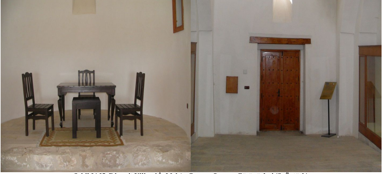
Şekil 24,25. Edremit Kilisesi İç Mekân Onarım Sonrası Görünümleri (Ş. Öztürk)
