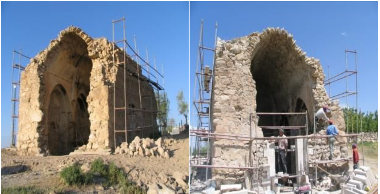
Şekil 18,19. Edremit Kilisesi Güneybatı ve Batı Onarım Görünüşleri (Ş. Öztürk)
