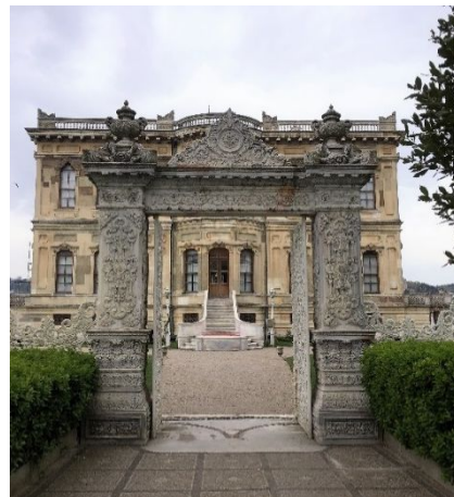
Şekil 8: Kasrı'nın Kara Tarafındaki Giriş Cephesi.
