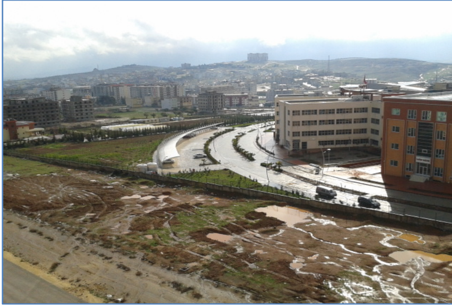
Foto 1: Kilis çevresinde doğal vejetasyon kuşağının yok edilmesi şiddetli yağışlarda oluşan su baskınları.
