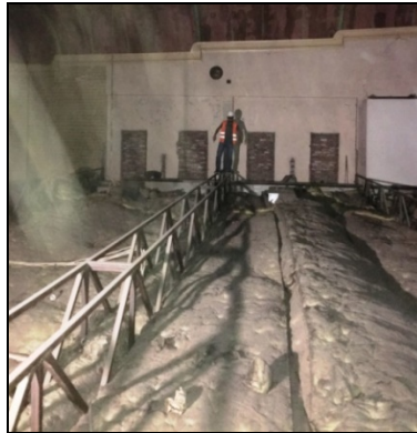
Şekil 18. Loca katında bulunan kapıların tuğla malzemeyle kapatılması
