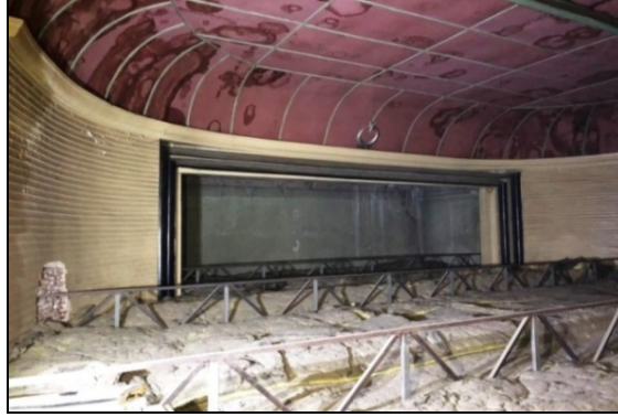
Şekil 9. Dilan Sineması Salon 2 ve Salon 3'ün üstündeki çelik makas sistem
