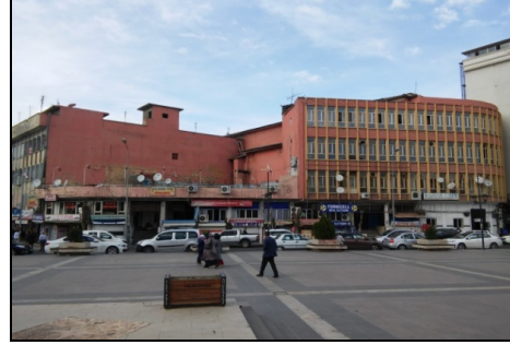
Şekil 3. Dilan-Site Sineması güneydoğu cephesi (2020)
