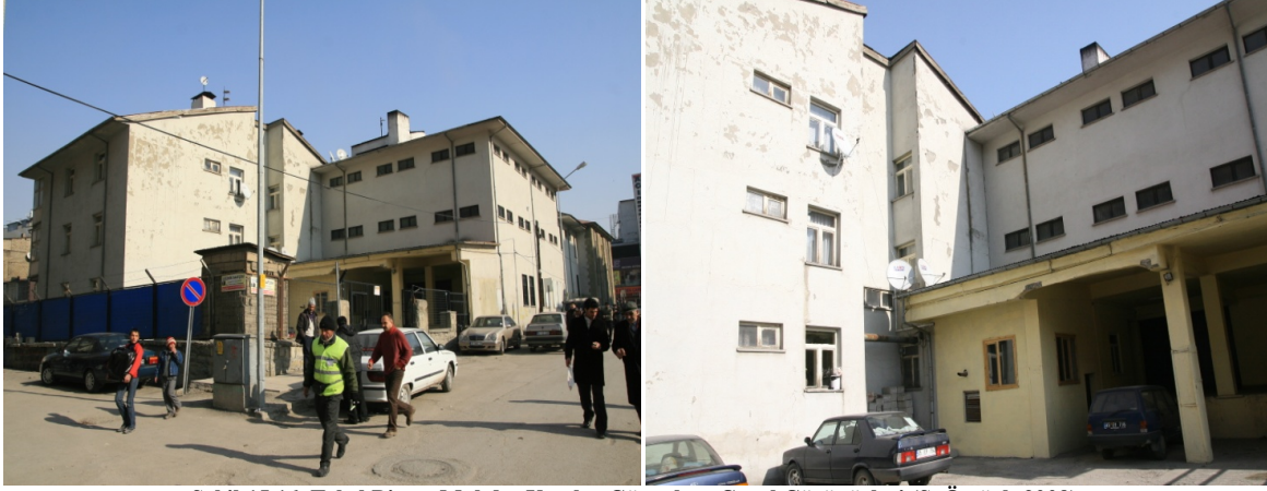
Şekil 15,16. Tekel Binasi Muhdes Yapılar Güneybatı Genel Görünüşleri (Ş. Öztürk:2009)
