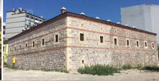
Batı ve güney cephesi
