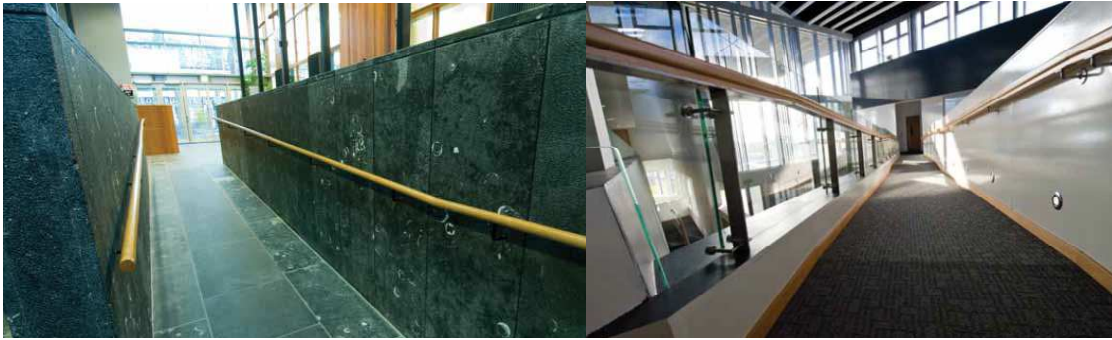
Şekil 5. Taş zemin kaplaması ve ahşap korkuluklu rampa örneği (URL1), Halı döşemeli rampa örneği (URL1)
