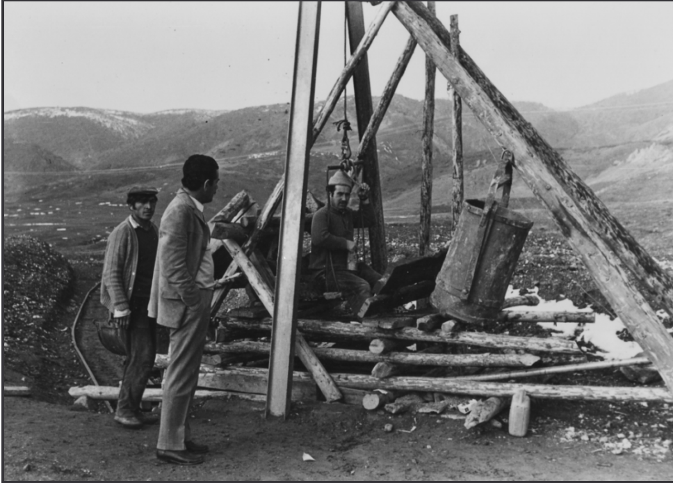
Foto 10: 1975 Yılında çıkırık yöntemi de denilen ve bugün de kullanılan maden ocağına girip çıkma düzeneği (Beyazaltın Köyü, Yılmaz arşivinden)
