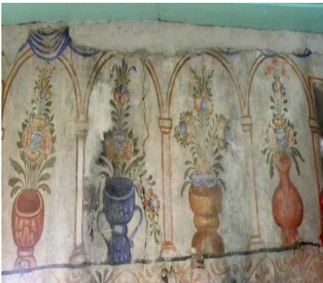
Fot.5: Kible Duvarı Üst Kısım Kalemîşi
